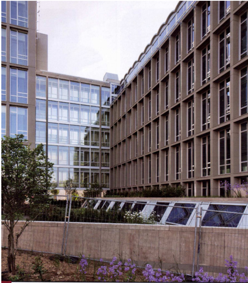
Een passerelle verbindt beide gebouwen over vijf verdiepingen heen. Op het gelijkvloers is er geen passerelle.
