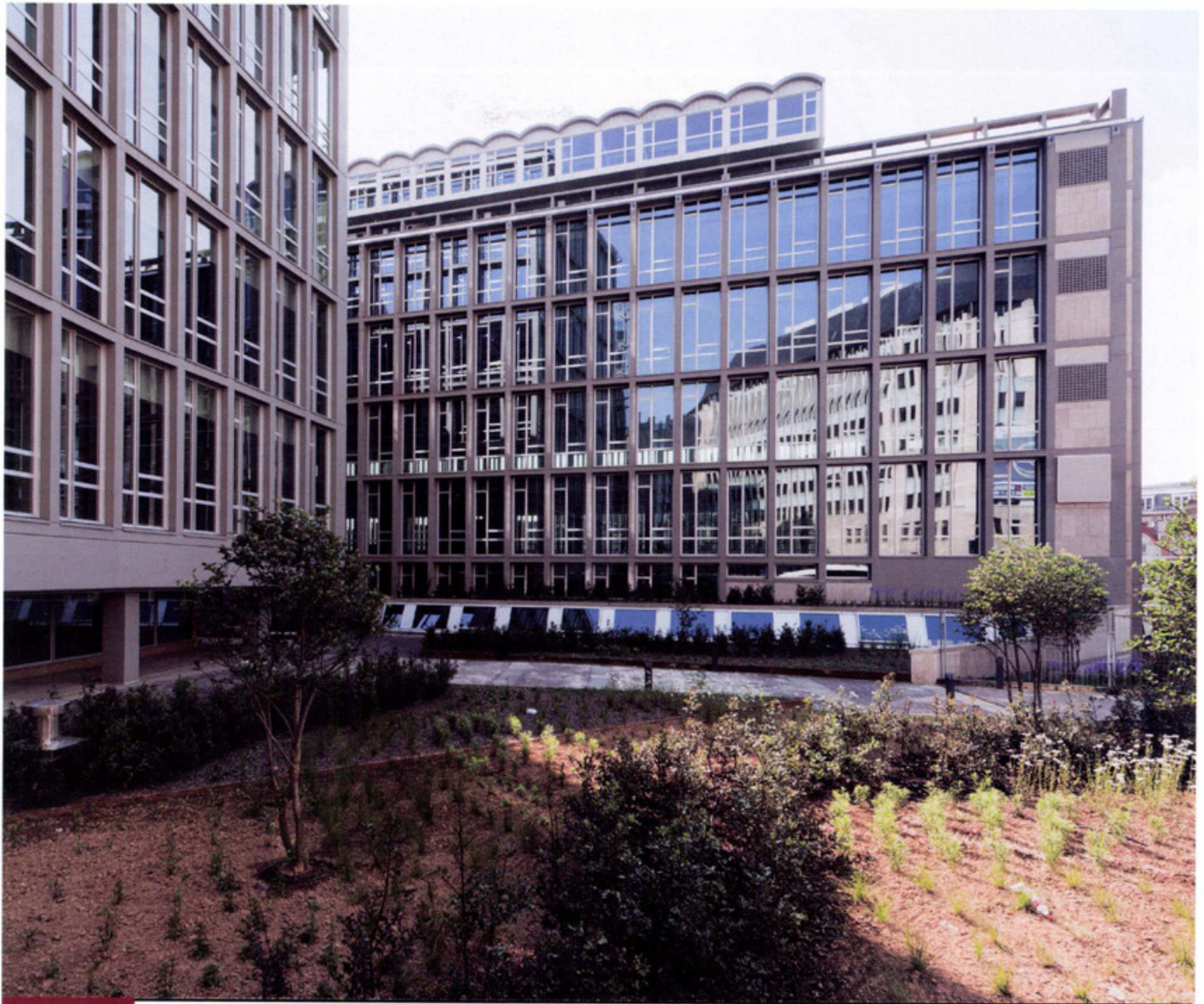
Een achteraanzicht op het gerenoveerde Telexgebouw.
